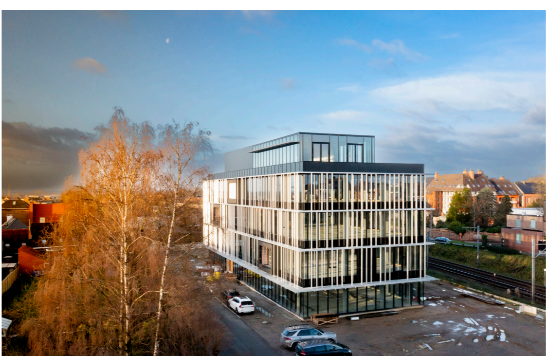
-Kantoor Aan het Spoor & rooftop bar 'De Kastaar'-
